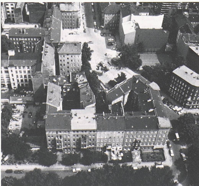
Bild 3. Baustruktur Berlin-Kreuzberg (Leuschnerdamm)
