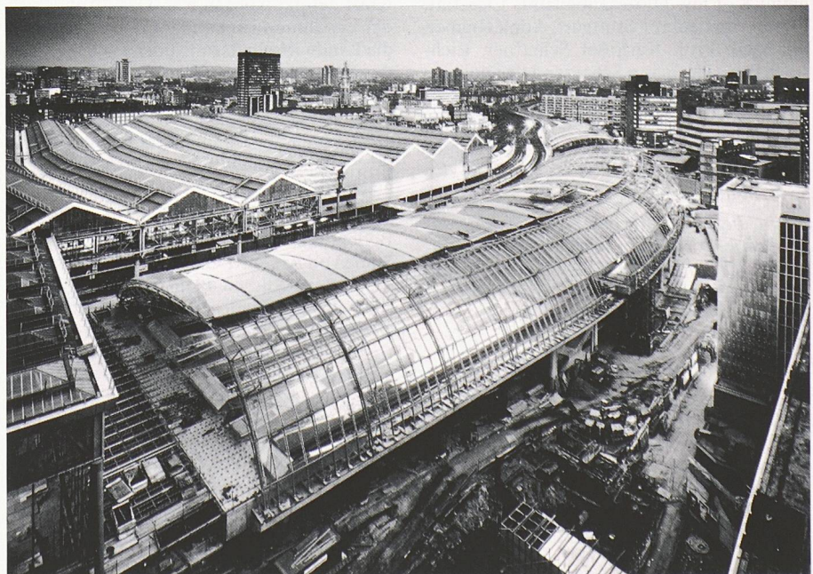
Die Bauarbeiten am neuen Bahnhof Waterloo International, Londons Tor für den Eisenbahnverkehr zum Kanaltunnel, sind bereits weit fortgeschritten. Durch ein grosses Glasdach wird das Halleninnere mit Tageslicht erhellt
