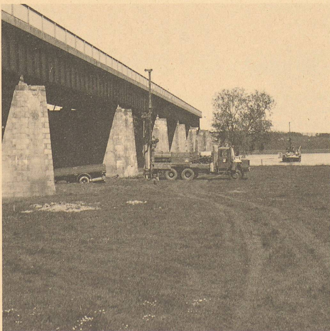
Elbbrücke bei Dömitz: erster Brückenschlag im vereinten Deutschland
