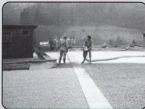
Absaugen von Kies, Sand und Humus ab Flach- dach, bei Baustellen und Kellern mit erschwer- tem Zugang.
