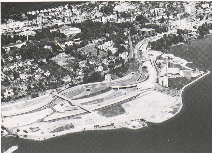
Umfahrung Neuenburg konnte in Betrieb genommen werden (Bild: Comet)
