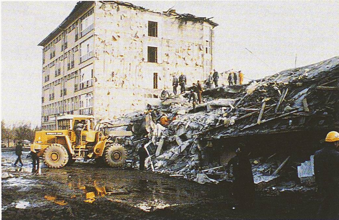
Bild 8. Richtung NNW eingestürzter, fünfstöckiger, L-förmiger Stahlbetonskelettbau eines Spitals in Erzincan
