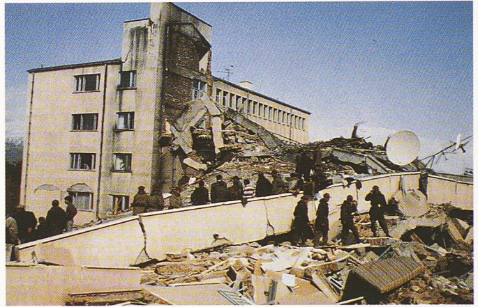
Bild 8. Richtung NNW eingestürzter, fünfstöckiger, L-förmiger Stahlbetonskelettbau eines Spitals in Erzincan
