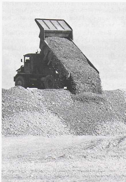
Abbaubarer Kies wird in der Schweiz langsam zur Mangelware. Vor allem im Tiefbau kann er teilweise durch Recycling-Produkte ersetzt werden (Bild: Comet)
