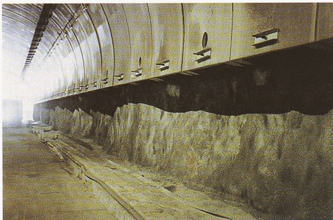
Bild 7. Abgetrennte Wandplatten mit permanenter (oben) und temporärer Anker-Sicherung bei den Ausbautypen D und E
