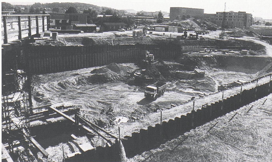
Ein Blick auf die Baustelle des neuen Wasserkraftwerks (Bild: Comet)
