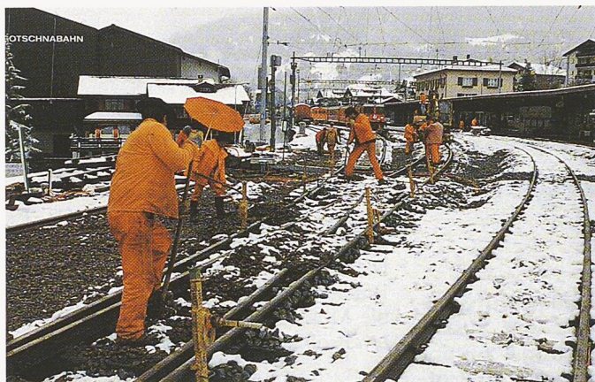
Bild 9. Gleisumbau im Oktober 1992 bei misslichen Wetterbedingungen
