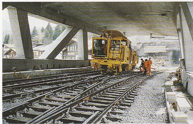
Bild 12. Stopfen der neuen Gleisdurchschneidung auf der Landquartbrücke beim grossen Umbau im April 1993
