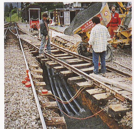
Bild 7. Auch einfachere Bauarbeiten sind im Bahnbetrieb behindert
