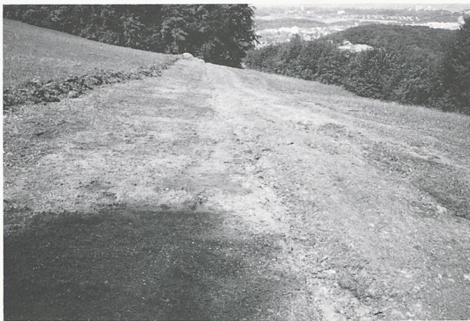
Bild 4. Beispiel Ober-Gruth, Gemeinde Münchenstein: In einer Wiese mit stark verdichtungsgefährdetem, tonreichem Boden wurde bei trockener Witterung nur der Grabenbereich abhumusiert und seitlich deponiert (Bild 4a). Einige Wochen nach Rückfüllung hat sich die Grasnarbe seitlich des Grabens gut erholt (Bild 4b)
