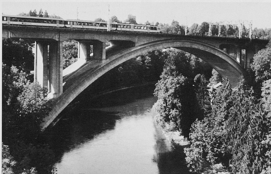
Der Kanton Bern ist nicht nur der eisenbahnreichste Kanton der Schweiz, er besitzt auch mit der Strecke Bern–Wylersfeld die am stärksten befahrene Linie des ganzen SBB-Netzes. Das über 50jährige Lorrainehalden-Viadukt über die Aare ist das imposante Kernstück dieser Linie (Bild: Comet)
