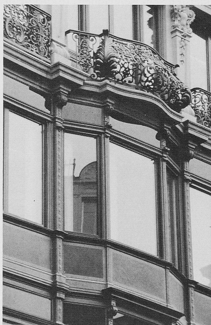
Europa-Nostra-Diplom für die Restaurierung des Geschäftshauses «Metropol» in Zürich, errichtet Ende letzten Jahrhunderts im Stil des Historismus von Stadtarchitekt Heinrich Ernst
