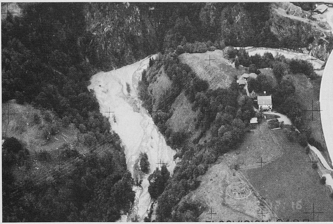
Bild 3. Der untere Teil der Schlüsselstrecke im Grindji. Unter der am rechten Bildrand noch erkennbaren Nationalstrassenbrücke befindet sich die Geschieberückhaltesperre. Blick in Fliessrichtung. (Foto P. Thee, Eidg. Forschungsanstalt für Wald, Schnee und Landschaft, Birmensdorf)
