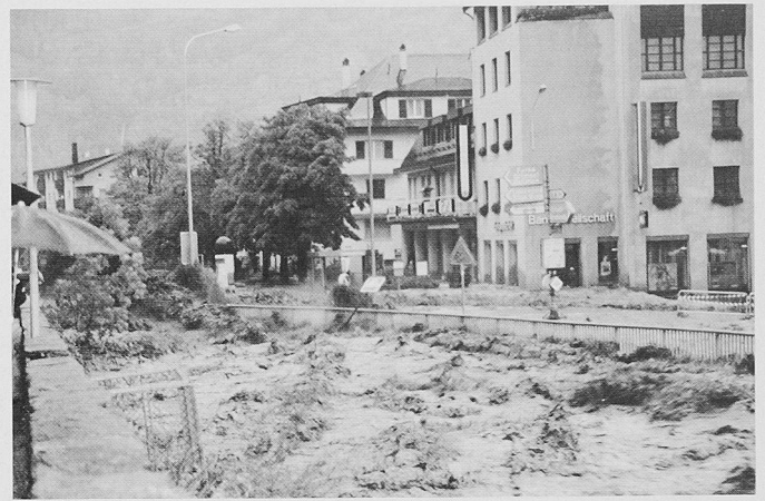
Bild 4. Die Saltinabrücke am 24. September 1993 kurz nach 16 Uhr. An der Brücke (erkennbar am Geländer) staut sich das Wasser und beginnt kontinuierlich auf die Brücke zu strömen. Blick in Fliessrichtung. (Foto I. Niederberger, Brig-Glis)
