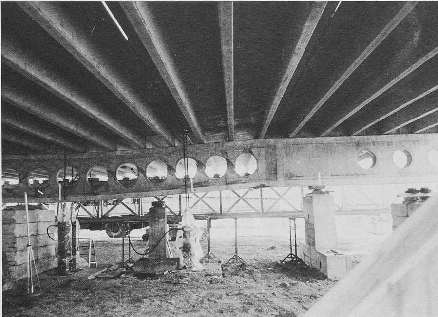
Bild 10. Verstärkung der Träger. Der Untergurt wird von einem U-förmigen Stahlträger umfasst. Der Zwischenraum ist mit Fließmörtel ausgegossen. Die Verstärkung muss im Raum zwischen Rohrleitungen und Unterdecke eingepasst werden
