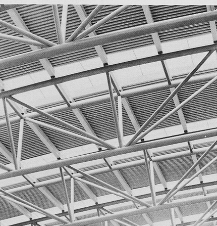
Bild 4. Die geschwungenen Hauptbinder sind als Rohrfachwerke mit Dreiecksquerschnitt zwischen den Hauptrohren ausgebildet
