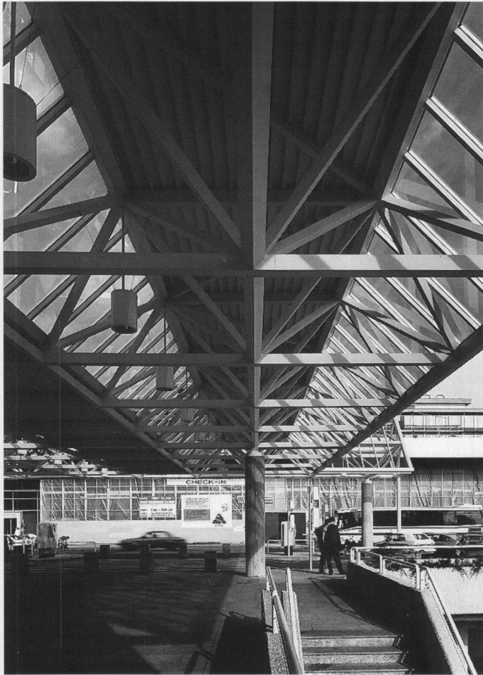
Fachwerke aus RHS-Profilen beim Bus-Terminal Flughafen Genf-Cointrin
