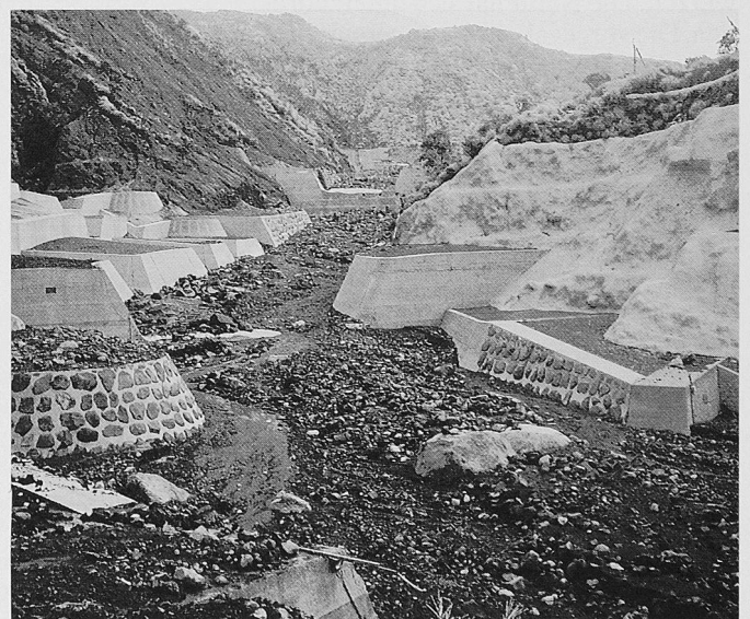
Bild 6. Klassischer Sperrenverbau am Mount Sakurajima soll eine gezielte Führung von Murgängen ermöglichen. (Foto: M. Jäggi)
