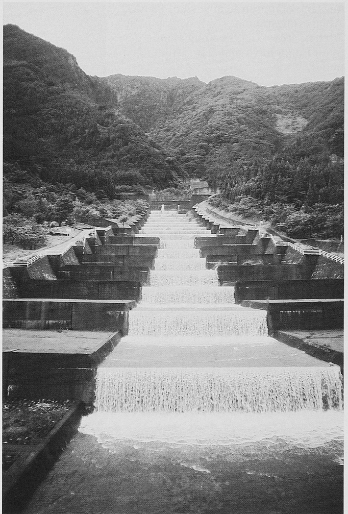
Bild 9. Flussverbauung in der Nähe von Hodaka (Foto: M. Jäggi)
