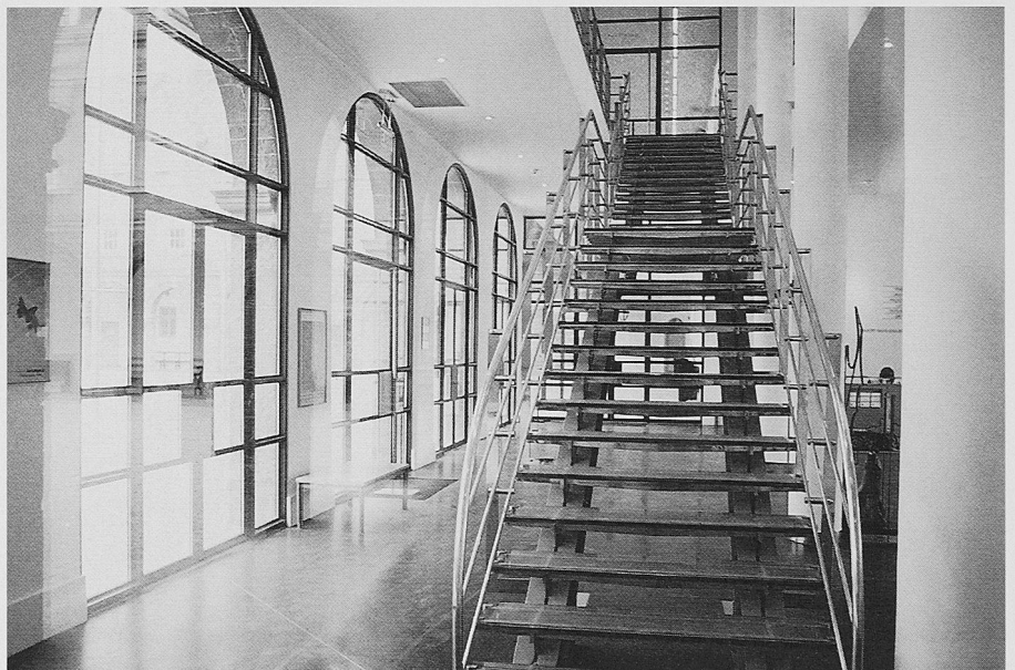
Irish Museum of Modern Art, Dublin, Shay Cleary, 1991. Umnutzung eines alten Spitals aus dem 17. Jh. Treppe als verbindendes Kunstwerk
