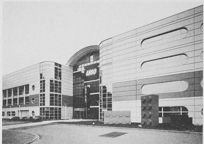
Lego-Produktion AG in Willisau, dessen energieoptimierte Gebäudetechnik von Sulzer Infra federführend ausgeführt wurde
