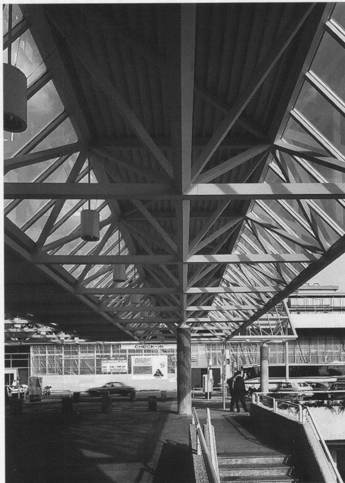
Fachwerke aus RHS-Profilen beim Bus-Terminal Flughafen Genf-Cointrin
