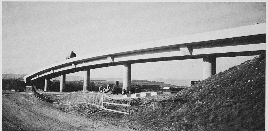
Bild 7. Überführung «du Milieu» über die N1 bei Avenches
