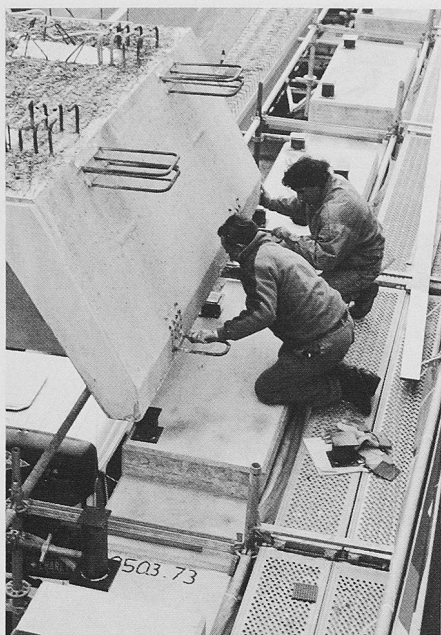
Bild 4. Die Elemente werden auf provisorischen Stahllagern montiert (November 1991, Foto H. Müller)
