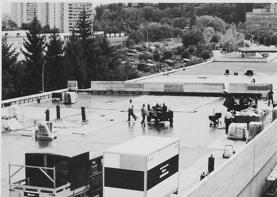
Bild 6. Abdichtung der fertigen Betonoberfläche der Überdeckung (Herbst 1992, Foto H. Müller)
