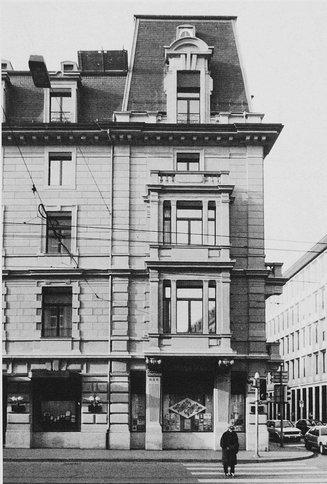
Fassade Bleicherweg. Eckturm Bleicherweg/Talstrasse mit Erker in Sandstein, siehe auch Plan der Hauptfassade Bleicherweg auf Seite 582
