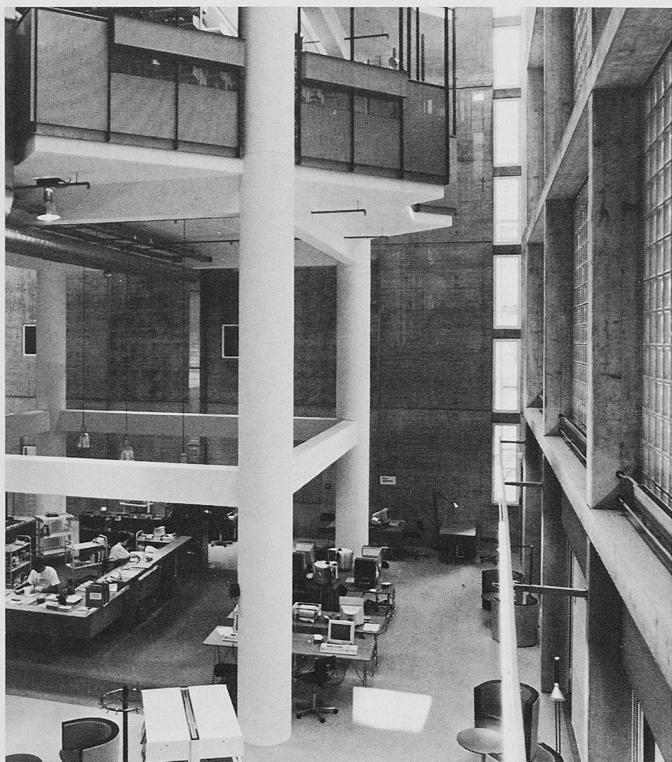
Rundstützen tragen die Bibliotheksplattformen
