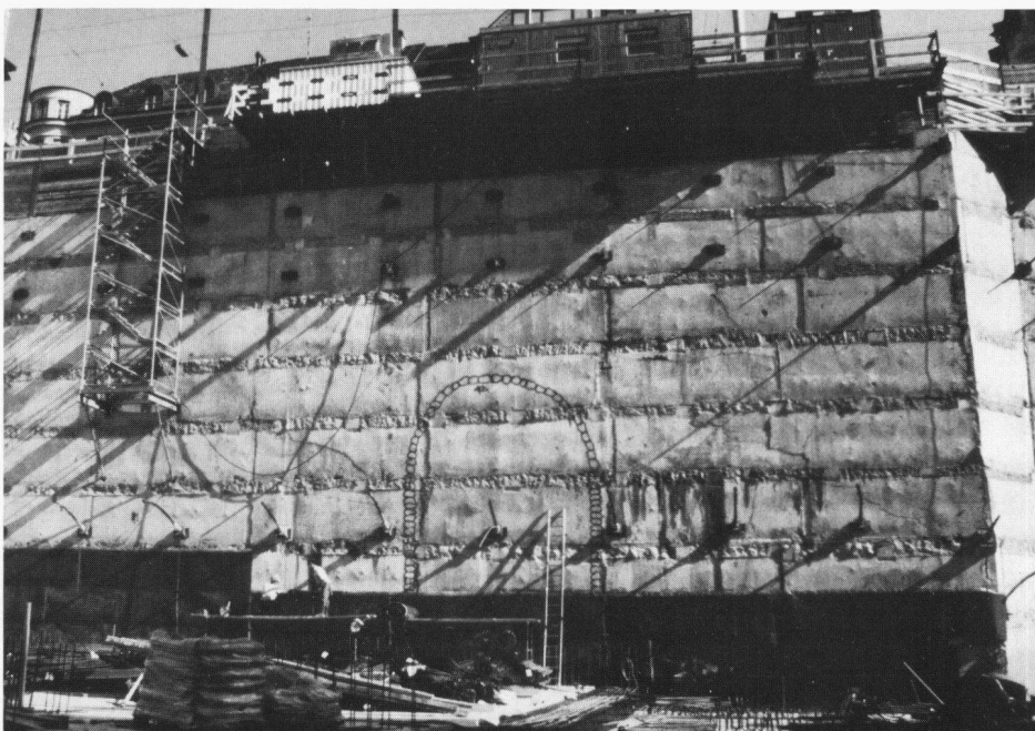
Enkadrain CK: begründete Zuversicht auch bezüglich Körperschallschutz bei diesem Bau am Kreuzplatz in Zürich (Sven Hotz, Generalunternehmung, Zürich)
