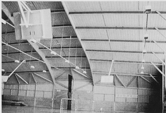
Bild 12: Sichtbar belassene Nail-Web-Träger als Dachpfetten und Fassadenstützen in einer Sporthalle
