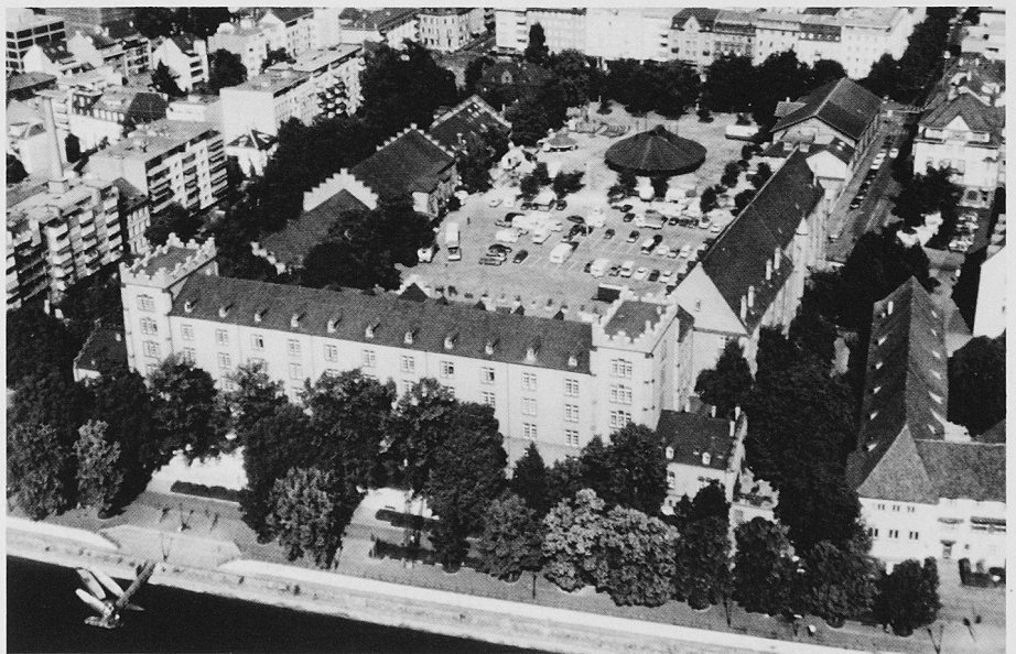
Für ihren Einsatz zugunsten der alten Kaserne Basel erhält die Interessengemeinschaft Kasernenareal ika den diesjährigen Heimatschutzpreis zugesprochen. Die neugotische Kaserne wurde 1863 errichtet und 1966 vom Militär wieder verlassen (Bild: H.-D. Flury, Basel)
