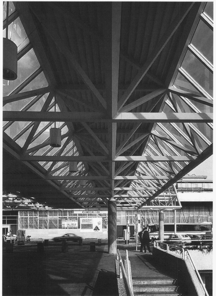
Fachwerke aus RHS-Profilen beim Bus-Terminal Flughafen Genf-Cointrin
