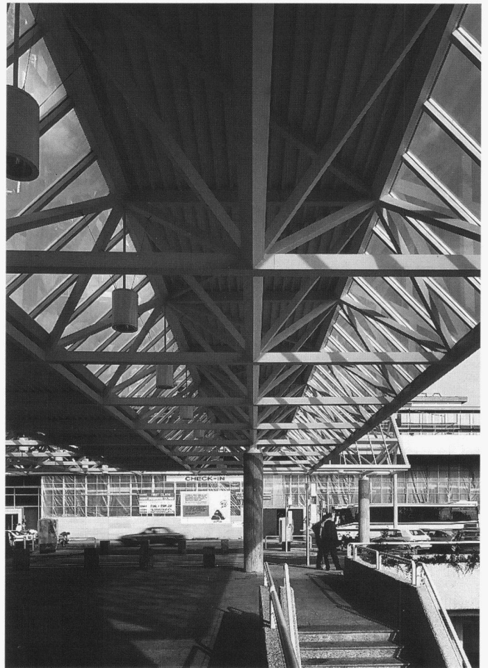
Fachwerke aus RHS-Profilen beim Bus-Terminal Flughafen Genf-Cointrin
