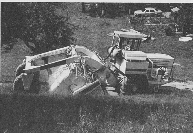
Raco 250: Fräsen des Koffers und evtl. anstehendes Material mit Belag, total 42cm stark, sowie Dosieren von C444 und Mischen in einem Arbeitsgang
