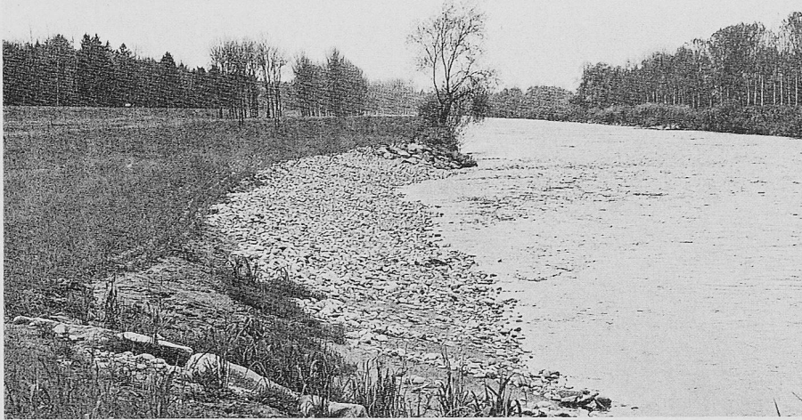
Bild 2. Wiederhergestellte Hochwassersicherheit der Thur unterhalb von Frauenfeld – naturnah
