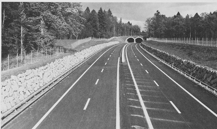
Bild 1. N7 Müllheim-Kreuzlingen mit sogenannter Grünbrücke
