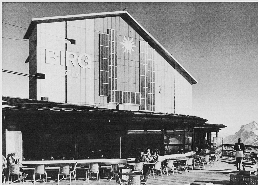
Der Kanton Bern macht vorwärts bei der Solarenergie: Bereits Anfang Jahr konnte auf dem Schilthorn eine neue Anlage bei der Bahnstation Birg eingeweiht werden. Sie gilt als Pilotprojekt. Auch das Drehrestaurant auf dem Gipfel erhält seit einiger Zeit durch Sonnenenergie den Strom für seine berühmten Aussichtsqualitäten (Bild: Comet)
