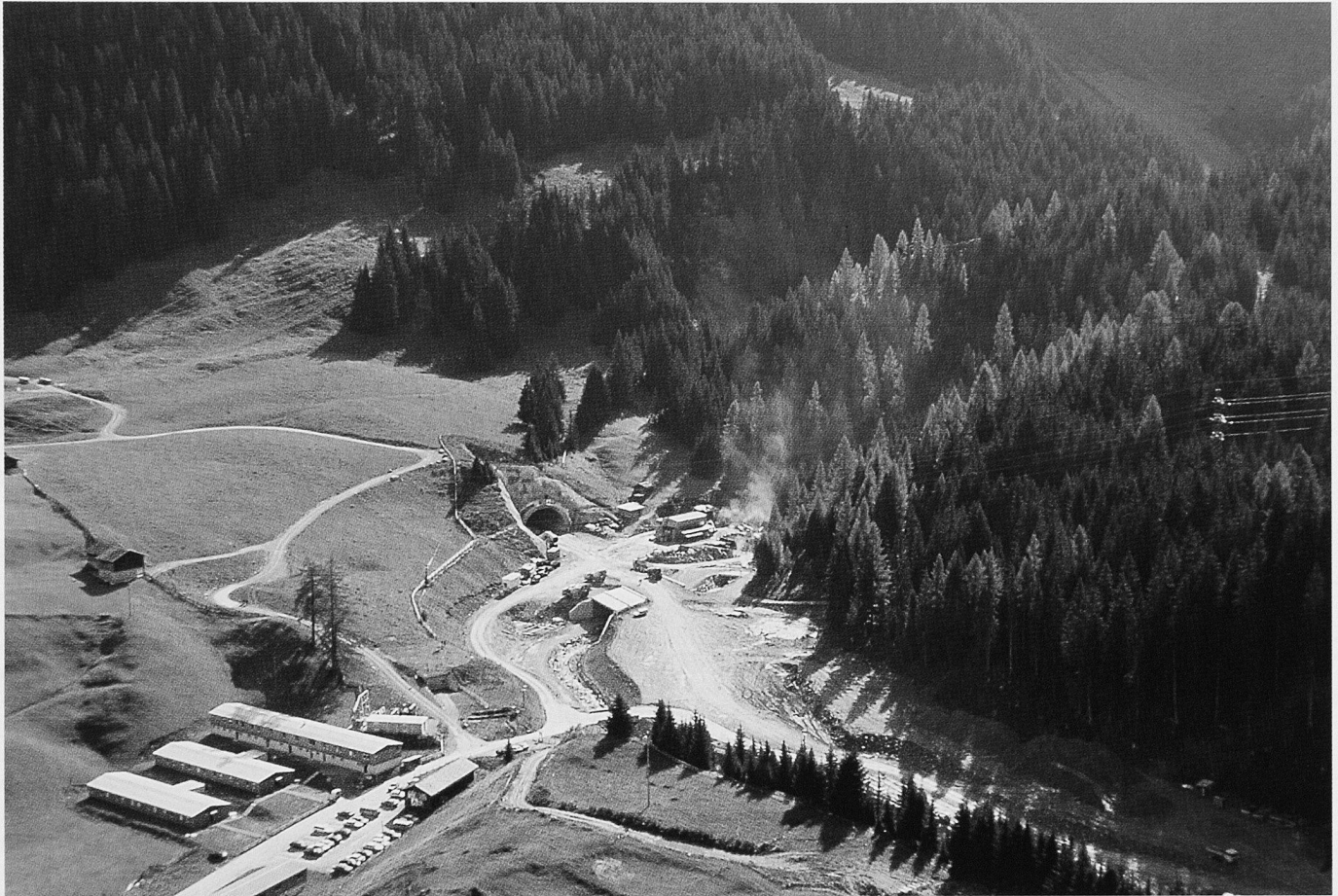
Bild 1. Baustellengelände Vereina Nord
