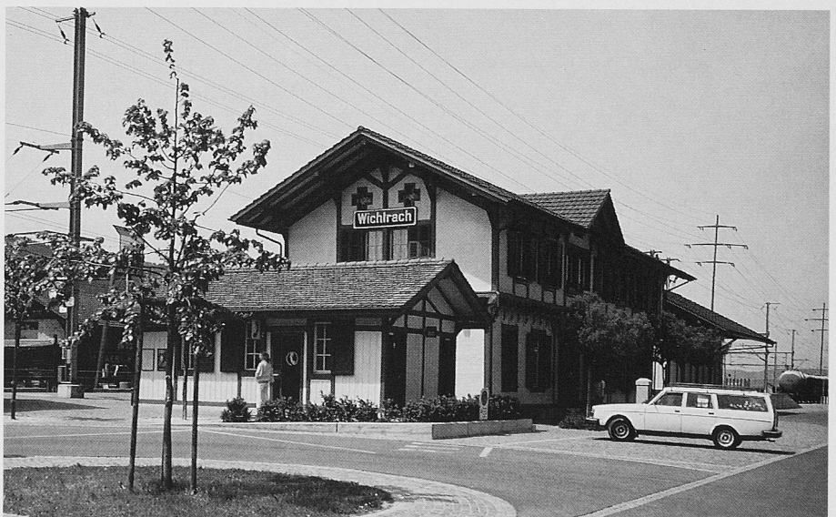
Bild 3. Die Bahn braucht auch neben der Schiene Energie: Bahnhof Wichtrach im Kanton Bern
