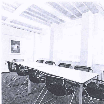
Bild 3. Beispiel einer offenen Decke in einem Sitzungszimmer
