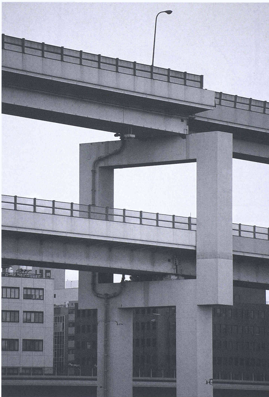
Bild 12. Beinahe-Absturz des oberen Brückenträgers
