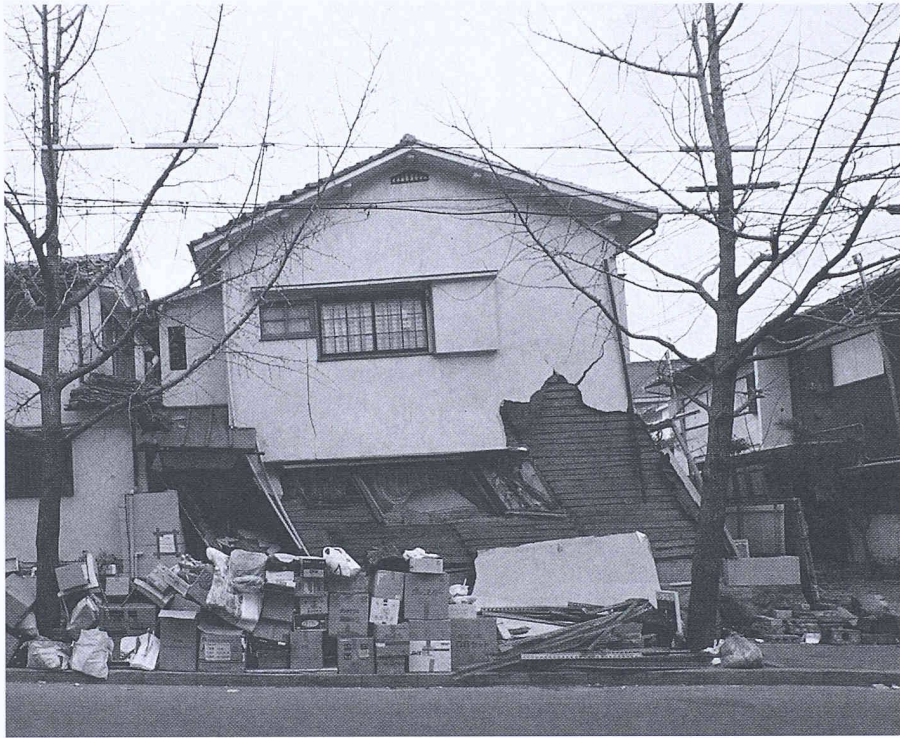
Bild 14. Nach links gekipptes Holzhaus («soft-story»-Effekt)
