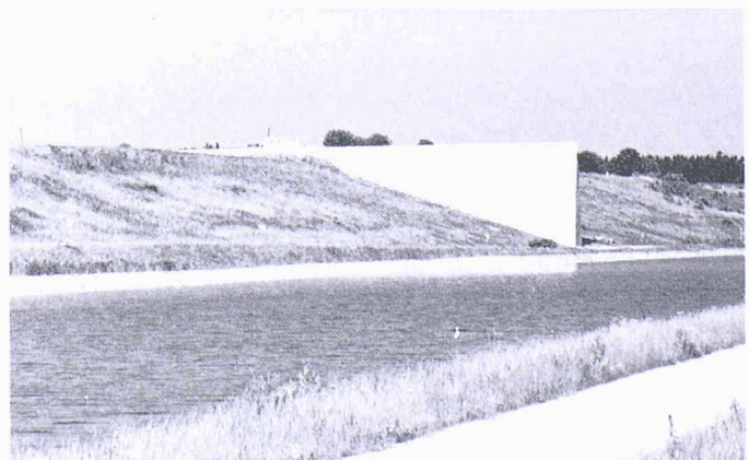
Bild 4. Scheitelhaltung bei Hilpoltstein. Eine Granitskulptur setzt hier ein weithin sichtbares Zeichen
