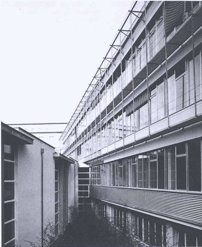
Unitobler: Hörsaal- und Lerchenwegtrakt mit Bambushof
