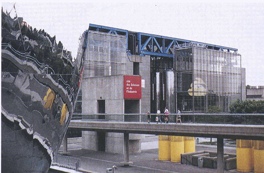
Bild 4. Gewächshäuser der Cité des sciences et de l'industrie von Aadrien Fainsilber und Peter Rice, Paris 1990. Hängende, mit vorgespannten Seilträgern senkrecht zur Glasebene gehaltene Tafelfelder aus sekurisiertem Floatglas
