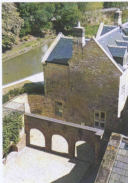
Blick vom Treppenturm auf das ehemalige Wohnhaus
