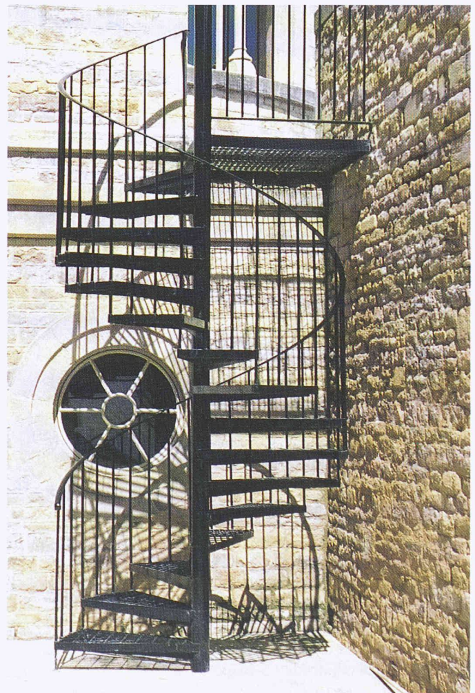
Nottreppe auf der Rückseite
