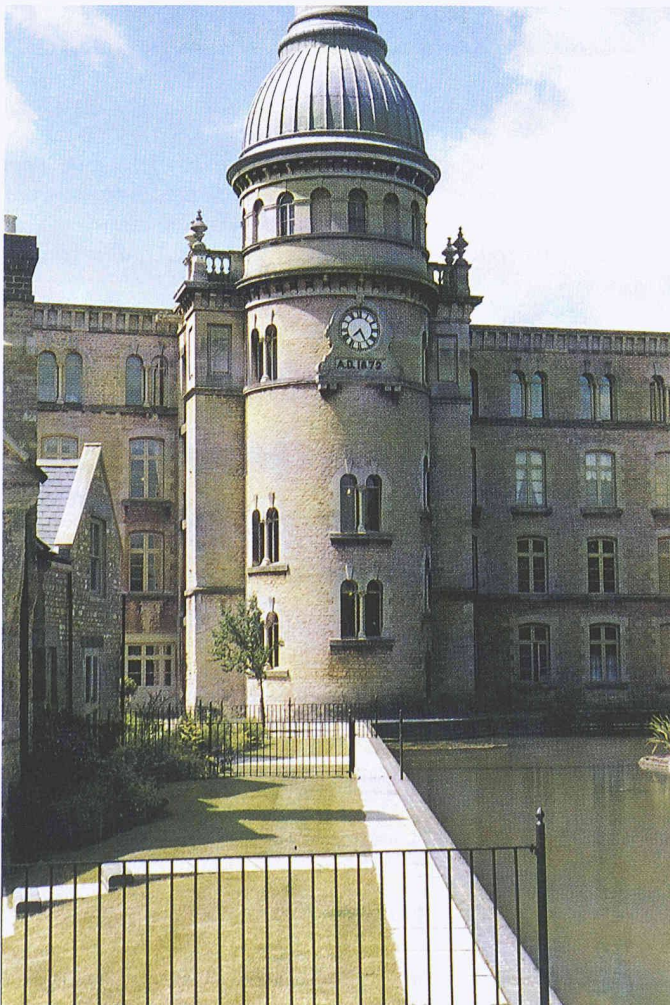
Ansicht Treppenturm auf der Rückseite
