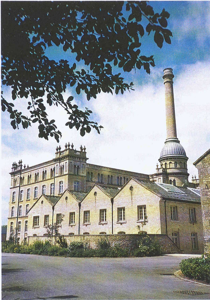
Ansicht von der Strasse, Einfamilienhäuser in ehemaligen Fabrikhallen
