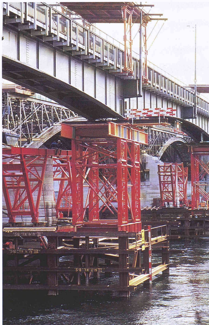
Bild 5. Montagegerüst mit Jochen und Schutz gegen Schiffsanprall, Legende: 2 Montagegerüst, 5 Schutz gegen Schiffsanprall, 7 Caisson
