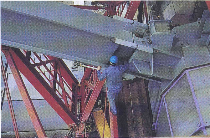
Bild 11. Provisorisches Verschrauben des Montaggestosses zwischen Auflagerkonstruktion und Bogensegment (Photo L. Rentsch)
