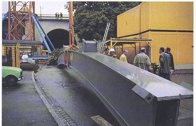
Bild 8. Bogensegment mit einem Gewicht von 32 t am Kleinbasler Ufer, bereit zum Anheben auf die Brücke mittels Turmdrehkran (Photo L. Rentsch)
