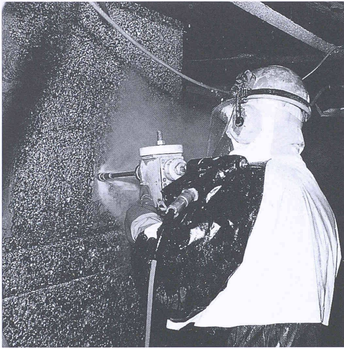
Bild 3. Lanzenführer beim Betonabtrag und Aufrauhn des Traggrundes mittels Wasser-Höchstdruck 2000 bar
