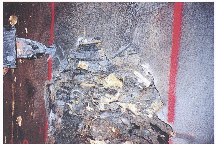
Bild 3. Das alte Tunnelgewölbe wurde in Breiten von 30 bis 50 Zentimetern aufgeschlitzt und ausgebrochen. Das alte Tunnelgewölbe und der gebräuchte Fels dahinter wurden mit Polyurethan verfestigt.
