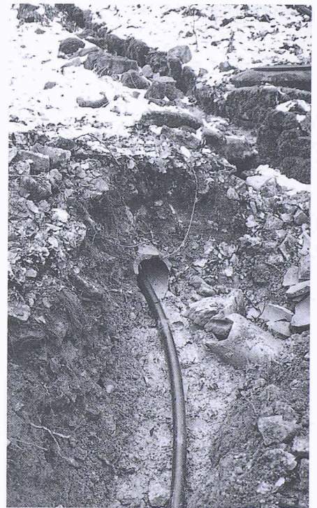
Einzug des Druckschlaches in eine alte Zementrohr- und Eternit-Wasserleitung
