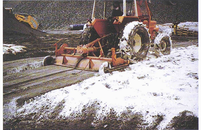
Aufbereitung der Abdichtungsmasse: Mischen mit der Bodenfräse
