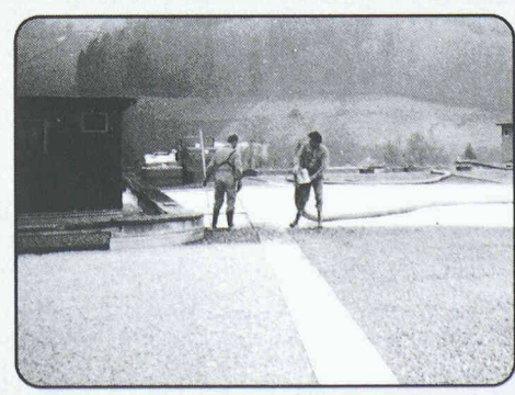
Absaugen von Kies, Sand und Humus ab Flachdach, bei Baustellen und Kellern mit erschwerem Zugang.
