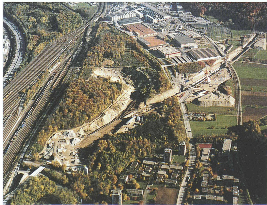
2 Flugaufnahme Tagbaustrecke Nord (Foto: Marc Eggimann)
