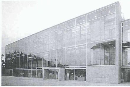
Erweiterungsbau der Uhrenfabrik «Corum» in La Chaux-de-Fonds (1991–1995). Architekten Margrit Althammer und René Hochuli, Zürich (Bild: R. Hochuli, Zürich)
