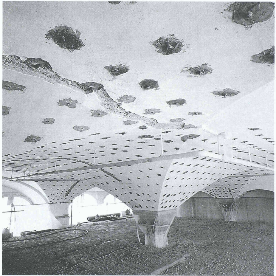
Gewölbedecke mit eingesetzten Bohrpäckern, Injektionsraster
