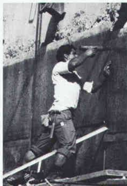
Problemlose Verlegung von Enkadrain CK auch auf unregelmässigem Untergrund
