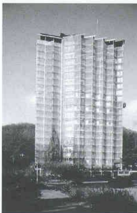
Kantonsspital Olten, Fassadensanierung Personalhaus
